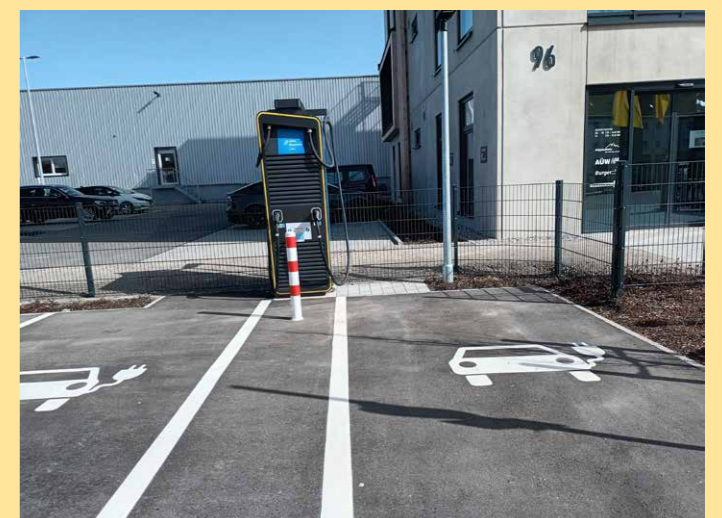
Ladeplatz (AÜW) zum Schnellladen am Schumacherring 96, Haus der Energie, Display auf der linken Seite ist bei belegtem linken Ladeplatz für Autofahrer im Rollstuhl nicht erreichbar.
